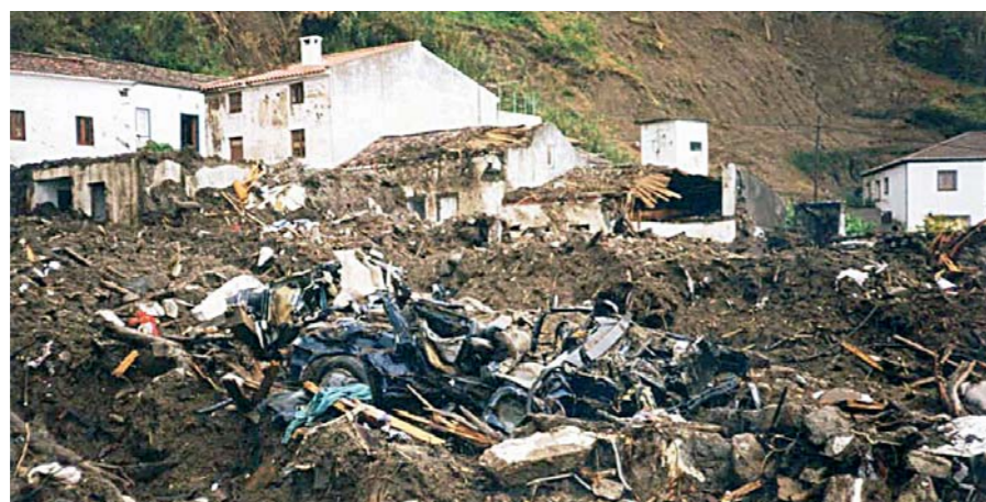
Fig. 2- Impacte dos movimentos de vertente desencadeados a 31 de Outubro de 1997 na Ribeira Quente
